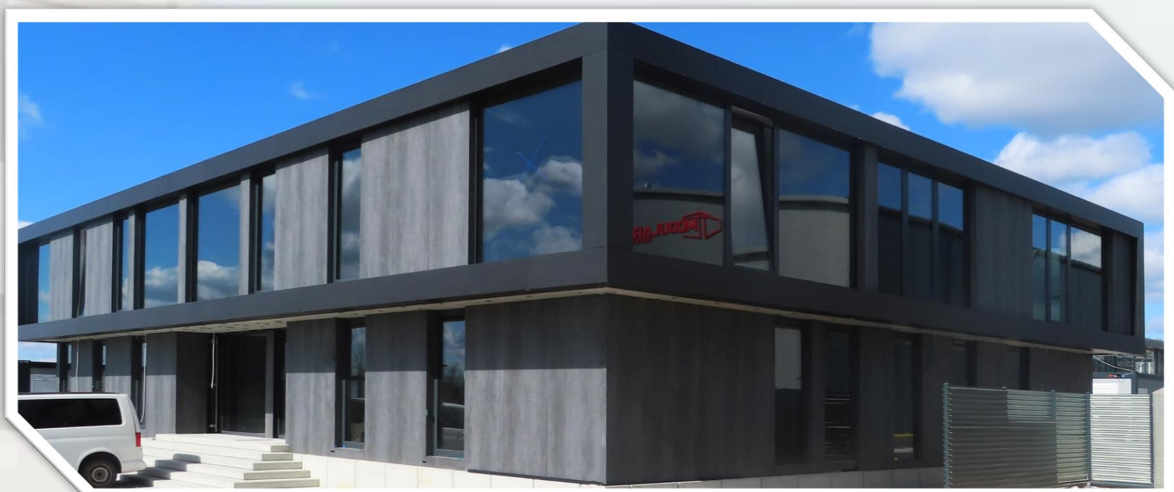
Rys. 1. Biuro wykonane w technologii modułowej.
